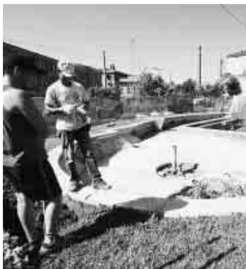
Controlli tecnici alla fontana in vista dei lavori
